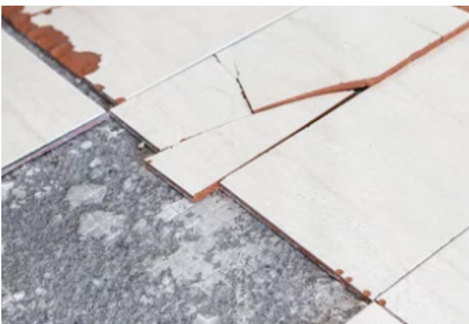
Ovan: Klinker. Höger: Asbestfibrer av sorten antofyllit påträffades i fix.
